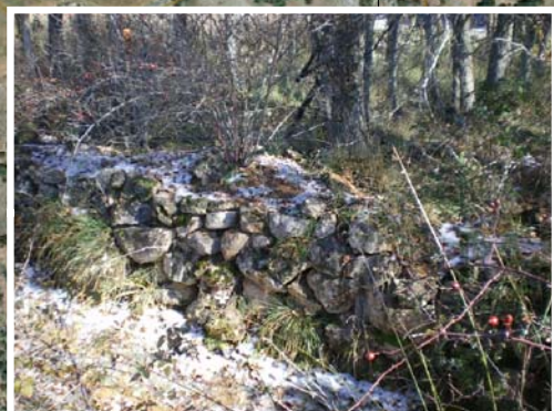
1.- MURO DE PIEDRA EN MARGEN DERECHO
