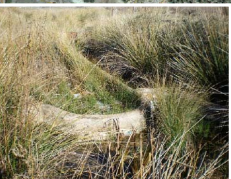
7.- AZUD "PRESA DEL LAVADERO"
